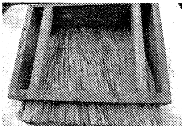
fot. 16 daszek na ul pokryty trzcina - widok od dołu
