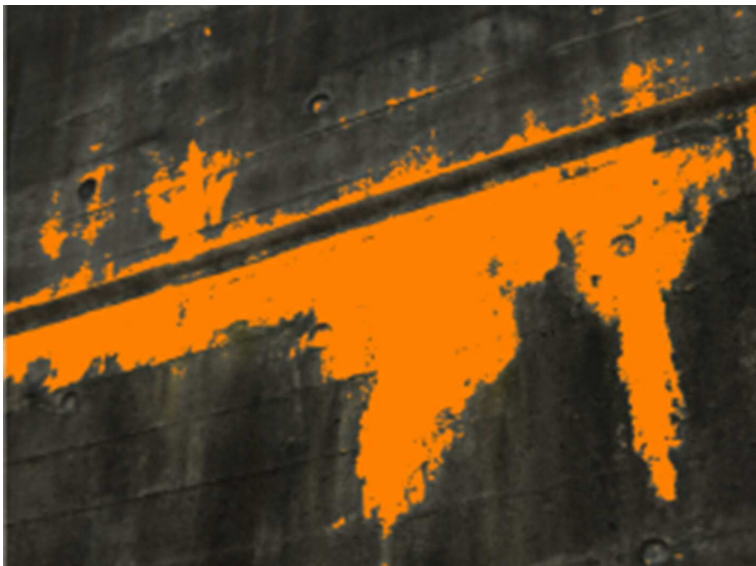
RGB 콘크리트 영상 백태 탐지 결과
